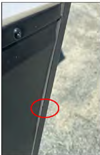
Curbside Sidewall Front Bottom Edge
